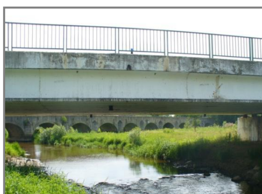
Foto 5 a 6 – Vtokový profil mostní konstrukce, včetně detailu zavázání křídla mostu do břehu
